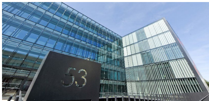
Villeurbanne (69) « Mirage » - 13 593 m 2 de bureaux
